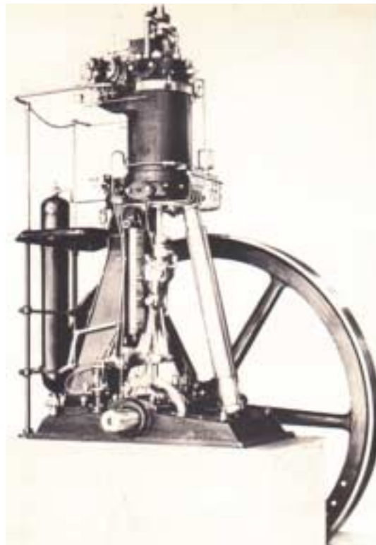
Abbildung 1.1: Erster Dieselmotor, entwickelt 1893 – 1897 in Augsburg 6 .
